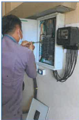
ภาพถ่ายที่ 2.2-25 การตรวจสอบระบบควบคุมไฟฟ้า MDB
