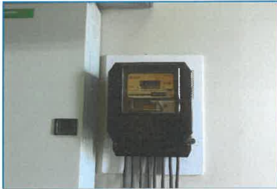
ภาพถ่ายที่ 2.2-15 ระบบมิเตอร์ไฟฟ้าของระบบ บำบัดน้ำเสีย
