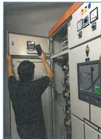
ภาพถ่ายที่ 2.2-25 การตรวจสอบระบบควบคุมไฟฟ้า MDB
