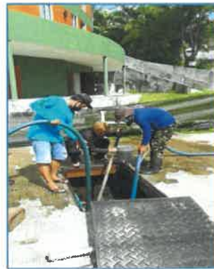
ภาพถ่ายที่ 2.2-17 การดูดกากตะกอนจากระบบบำบัดน้ำเสีย
